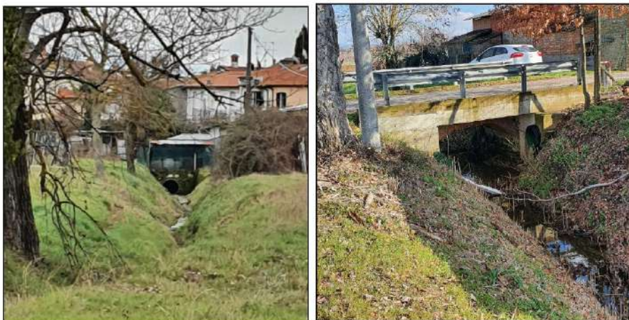
Figura 3.6 – a sinistra, l'uscita del tratto tombato del Rio del Basso; a destra, il Ponte della Morte lungo il Rio Pescaia
